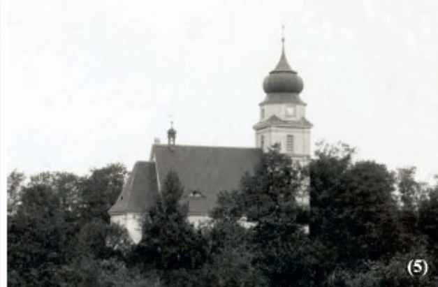
Kościół przed rozbudową oraz współcześnie Picture of the church before expansion and at present Фото костела перед розбудовою та сучасний вигляд Foto der Kirche vor dem Ausbau und zeitgenössisch
